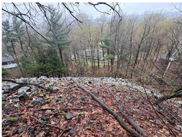
La vue de deux résidences au pieds du talus.
