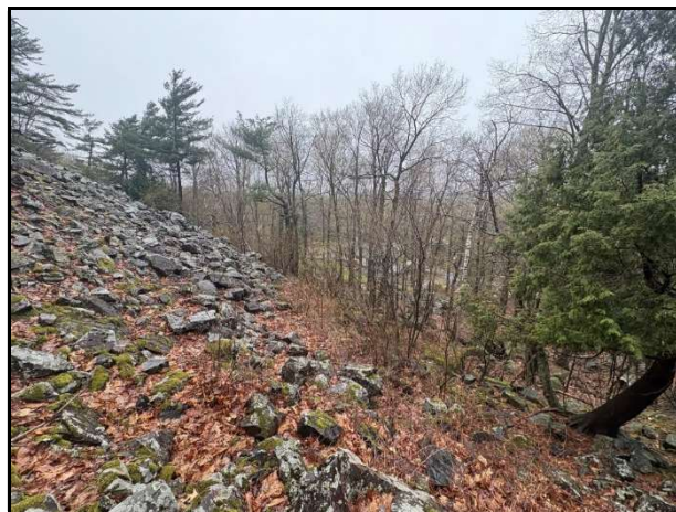
Deuxième zone d'éboulis et une résidence au pieds du talus.
