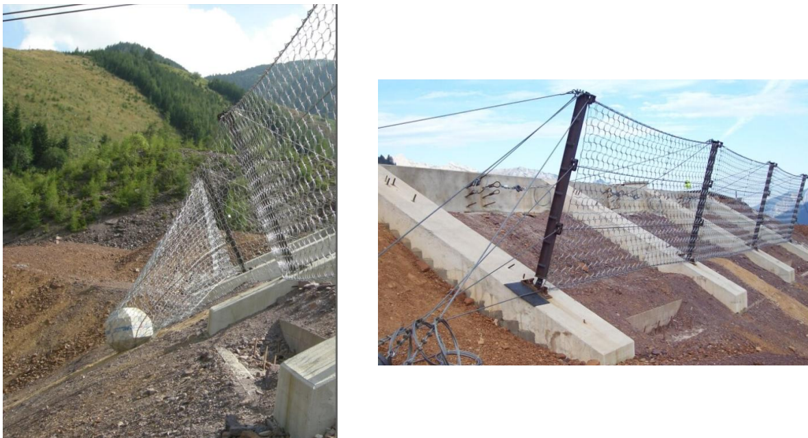
Figure 6 : Exemples d'atténuateurs utilisant des installations d'écran dynamique
