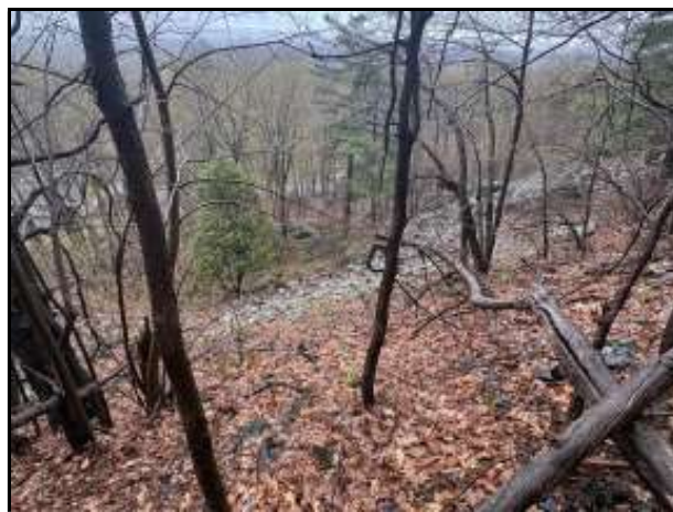
Une vue de pied de la paroi avec la vue de la résidence au pieds du talus .
