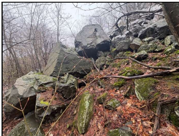
Vue des blocs de rocs instables.
